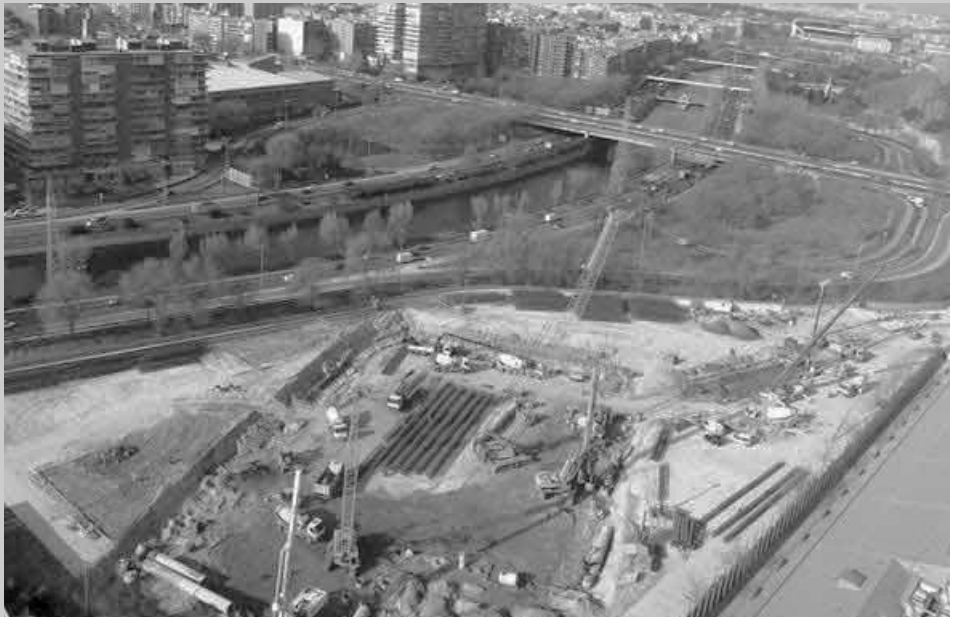
Obras en el nudo Sur de Madrid de la M-30.
