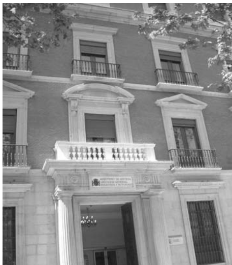
Registro Civil Central, en su nueva sede de la Plaza de Benavente, Madrid.
